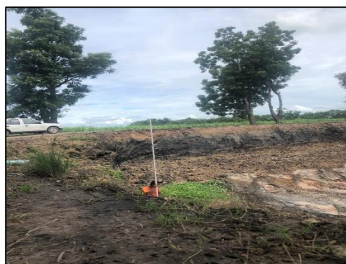
ภาพที่ 39 คันบ่อน้ำหมุนเวียน และคันบ่อบำบัดน้ำเสีย
