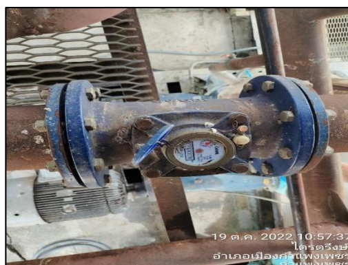
ภาพที่ 30 ติดตั้งมาตรวัดน้ำ บริเวณปั้มนสูบน้ำ และระบบผลิตน้ำใช้
